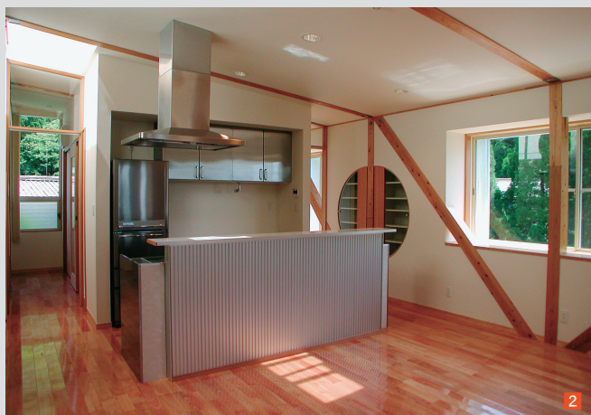
①鉄筋コンクリートの基壇に集成材のトラスを載せた。耐震性に優れ、外壁のガルバニウムが清々しい②スギ材によるトラス構造と登り梁によって、内部は大空間に
